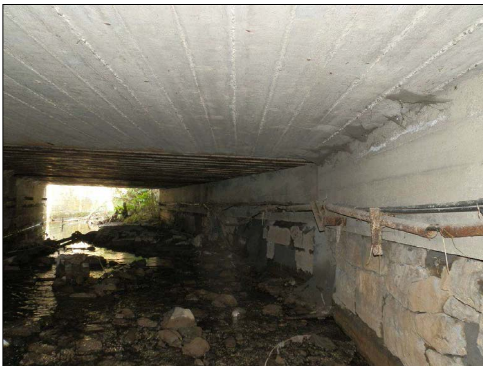
Obr. č. 10 - opěra Plzeň pod první a druhým levým rozšířením. Mostní prahy jsou z betonu, spodní stavba z kamenného zdiva.
