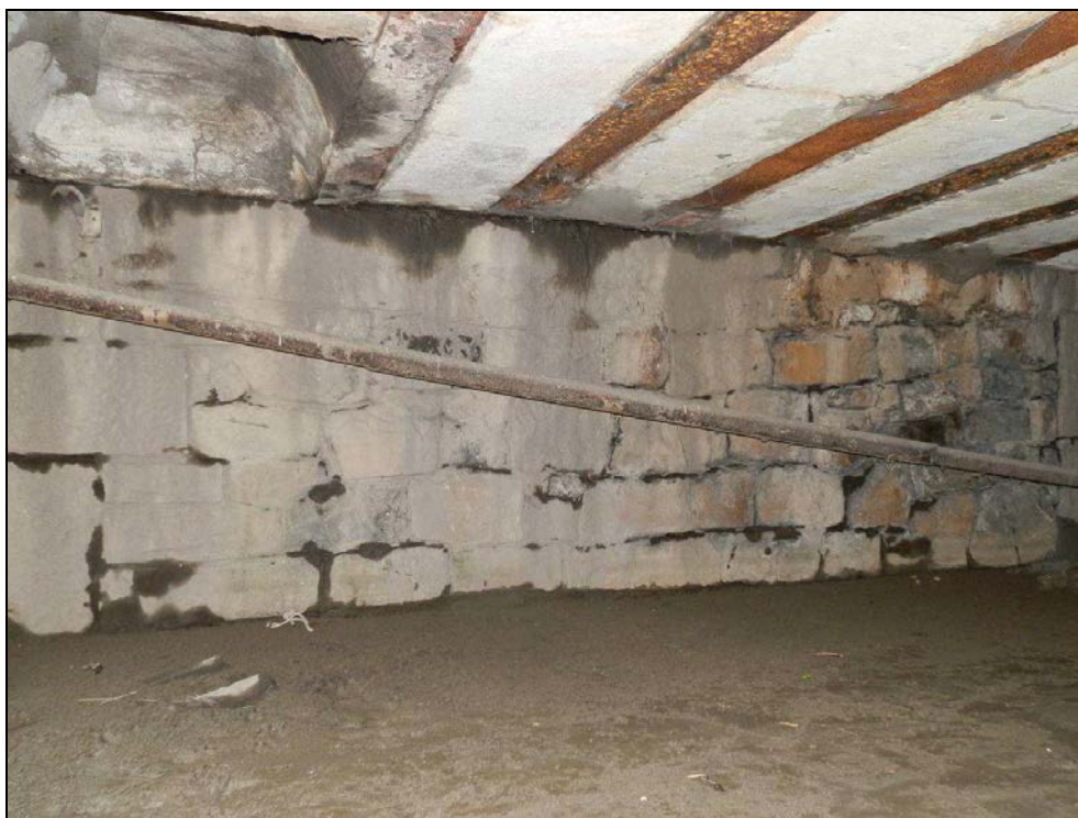
Obr. č. 6 - opěra Praha pod původní částí objektu. Zdivo je mokré.
