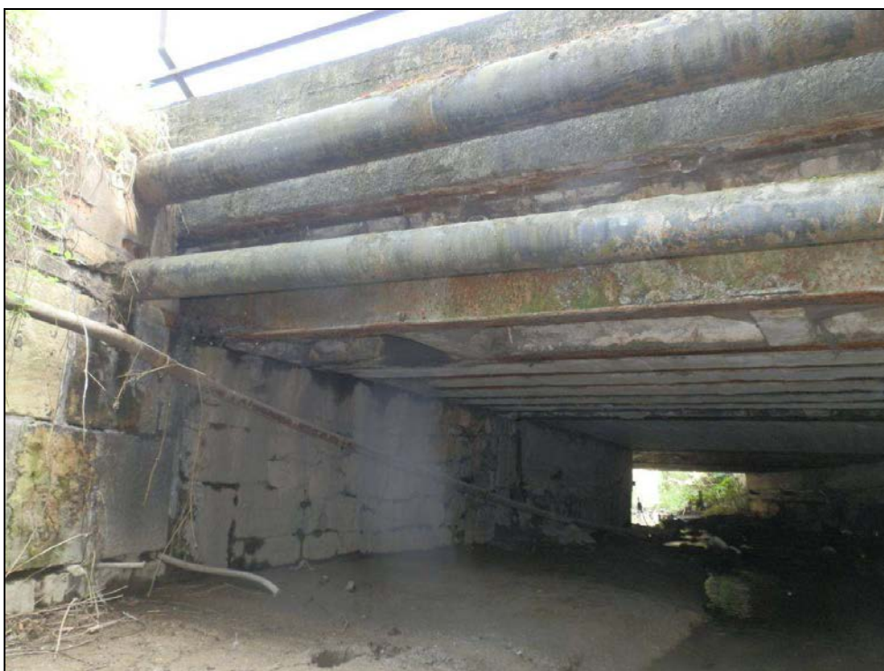
Obr. č. 5 - detailní pohled zprava na pravé čelo. Krajní nosníky NK jsou obnažené a přístupných plochách postižené celoplošnou povrchovou korozí, která je místy až hloubková
