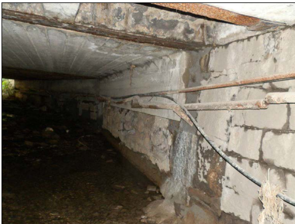
Obr. č. 7 - opěra Plzeň v místě kontaktu původní části a prvního levého rozšíření. Na kontaktu stéká na spodní stavbu z dilatační spáry voda.
