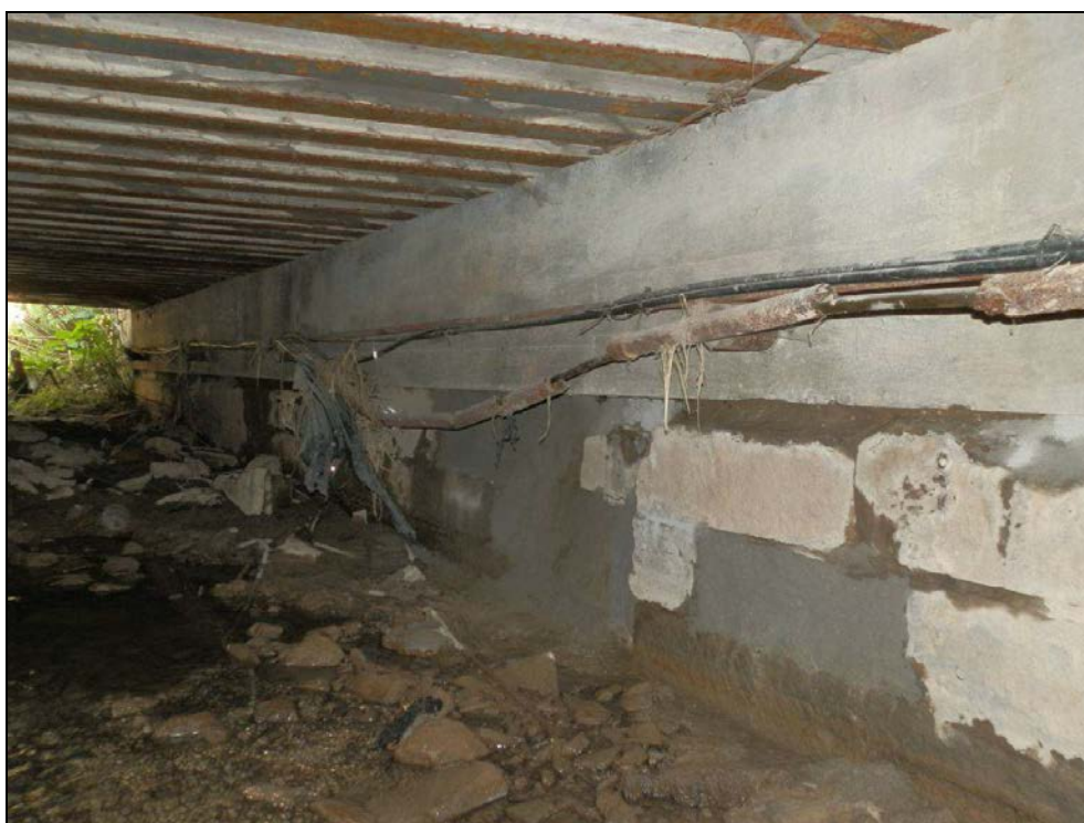
Obr. č. 13 - opěra Plzeň u druhého levého rozšíření, nosná konstrukce je zde ze zabetonovaných nosníků
