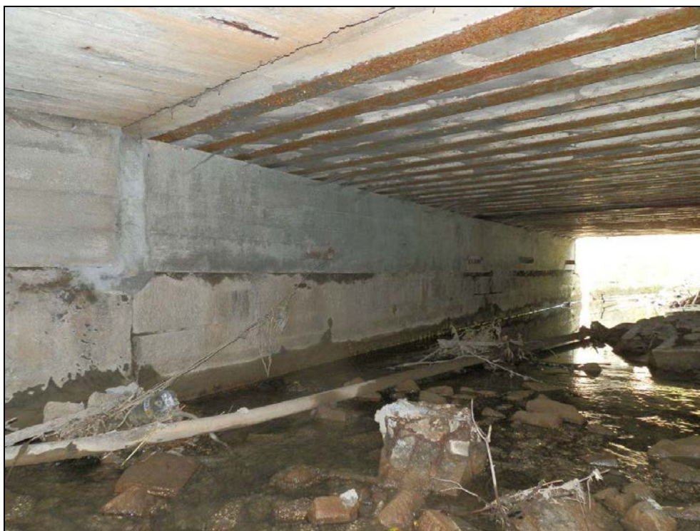
Obr. č. 12 - opěra Praha u druhého levého rozšíření, nosná konstrukce je zde ze zabetonovaných nosníků
