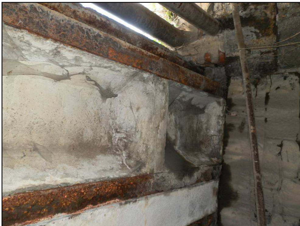
Obr. č. 8 - nosná konstrukce ze zabetonovaných nosníků. Nosníky jsou na obnažených místech celoplošně zasaženy povrchovou korozí, která místy přechází od koroze hloubkové.
