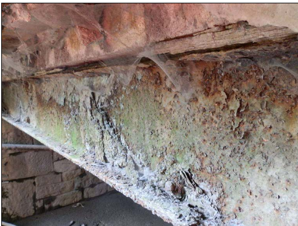
Obr. č. 15 - detail ocelového nosníku u původní části objektu. Nosník je obnažený a je s celoplošnou povrchovou korozí, místy se jedná o korozi hloubkovou
