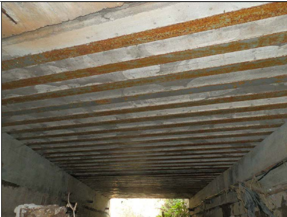
Obr. č. 14 - NK nad druhým levým rozšířením, nosná konstrukce je zde ze zabetonovaných nosníků
