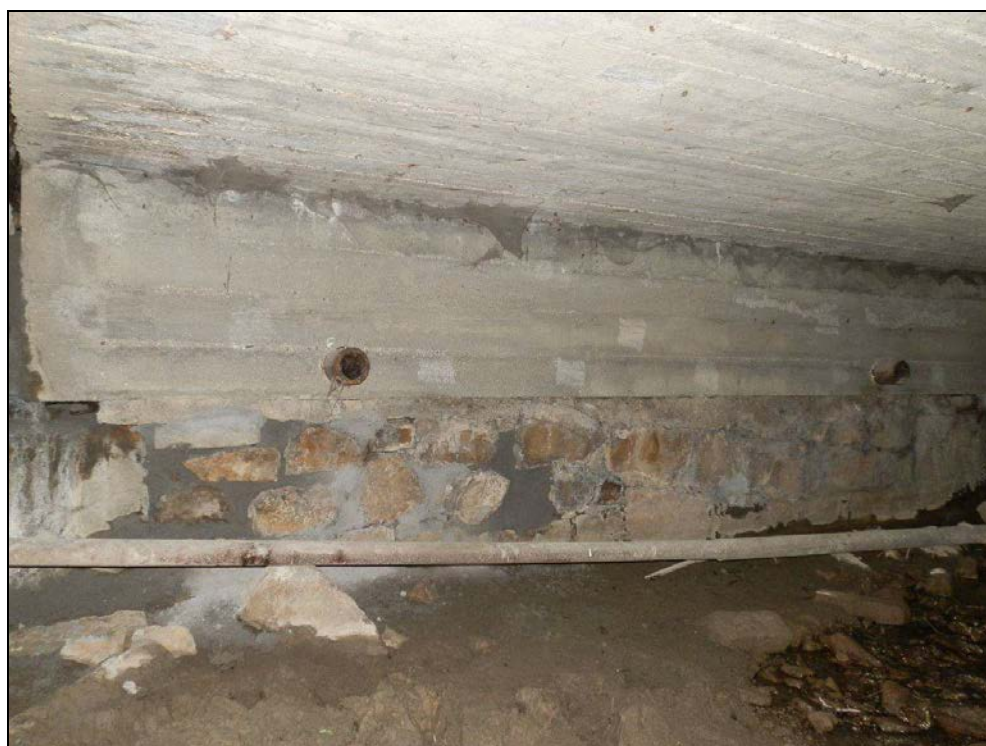
Obr. č. 9 - opěra Praha pod první levým rozšířením. Mostní práh je z betonu, spodní stavba z kamenného zdiva.
